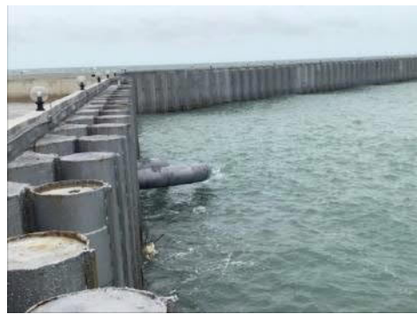
写真:ポンドタイプの取水口
