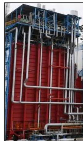
写真右：排熱回収ボイラー
