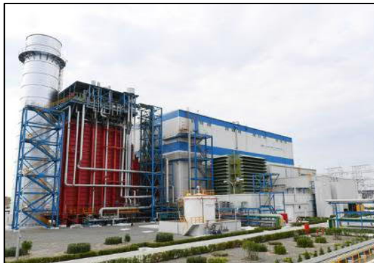
シマル発電所 2 号機全景
