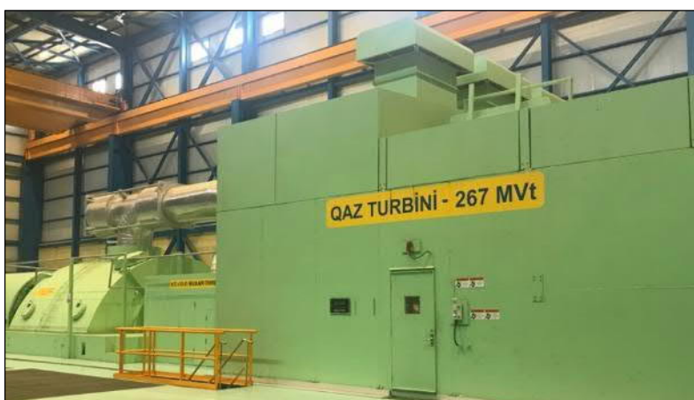
写真左：蒸気タービン(左奥)とガス・タービン（手前）
