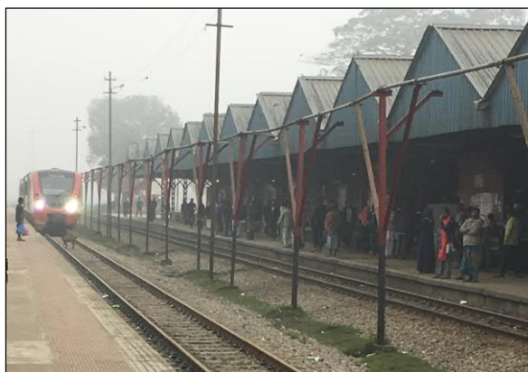
本事業により複線化された線路
