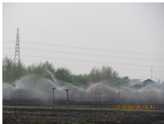
本事業で整備されたスプリンクラー設備
