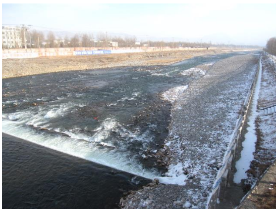
本事業で実施された河川護岸工事
