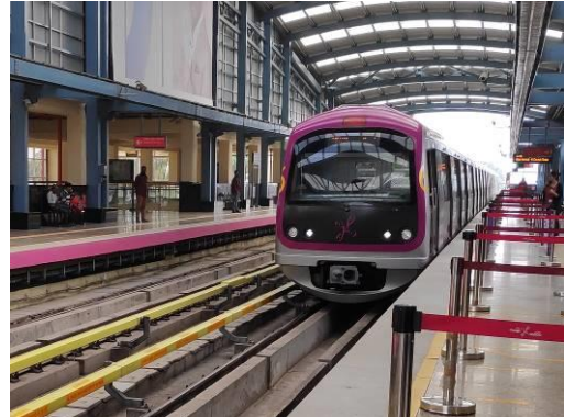
本事業により整備されたバンガロール・メトロ東西線
