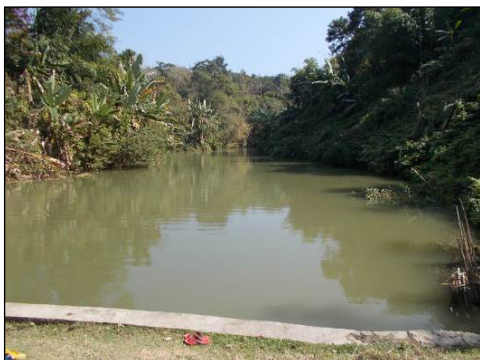
建設されたチェックダム
