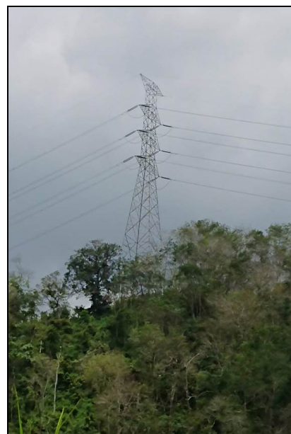
本事業の送電ルートにある森林地域の丘に建設された送電鉄塔
