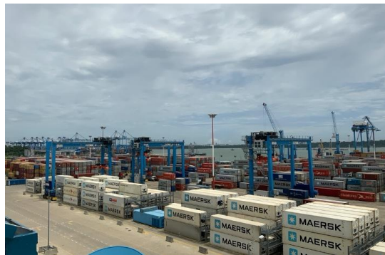
新設された第2コンテナターミナル
