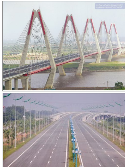
本事業により整備された ニャッタン橋（日越友好橋）と連絡道路
