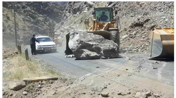
道路現場での日常保守が進行中
