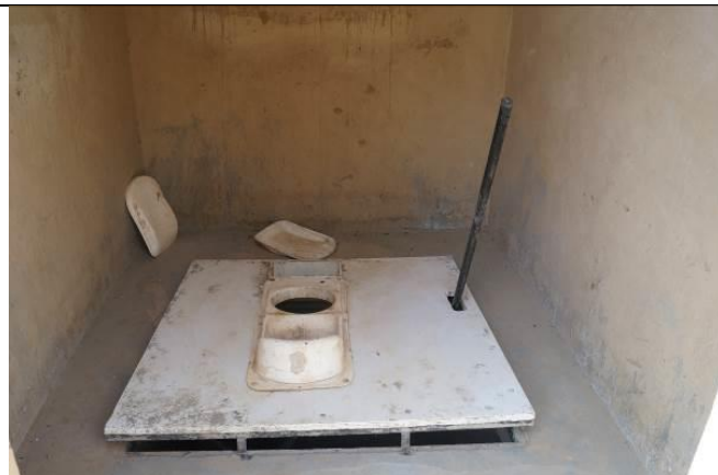
バルクンドゥバ村に設置されたコンポストトイレ
