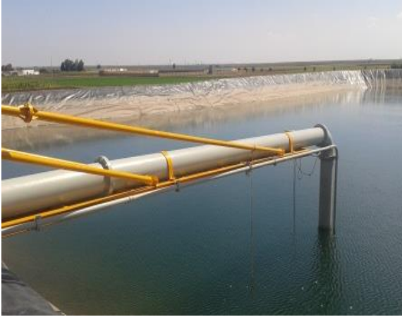
事業実施中の灌漑用水貯水池(2011年ー2016年)
