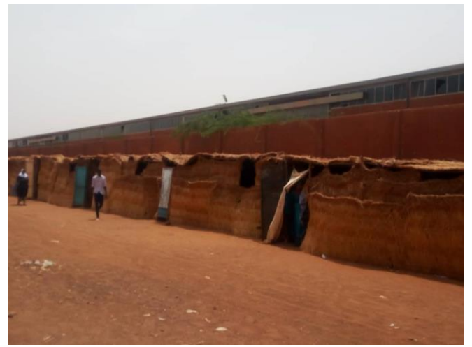
ペイ・バ 1&2 小学校にある、CGDES により建設された 「15 の藁ぶき校舎の学校」
