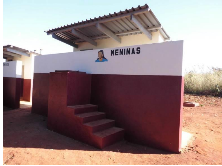
本事業で建設された学校用トイレにより、小学校の衛生は改善した。
