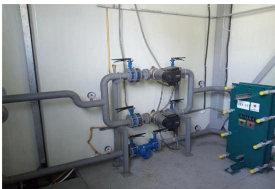
写真4：ペレットボイラーの接続配管
