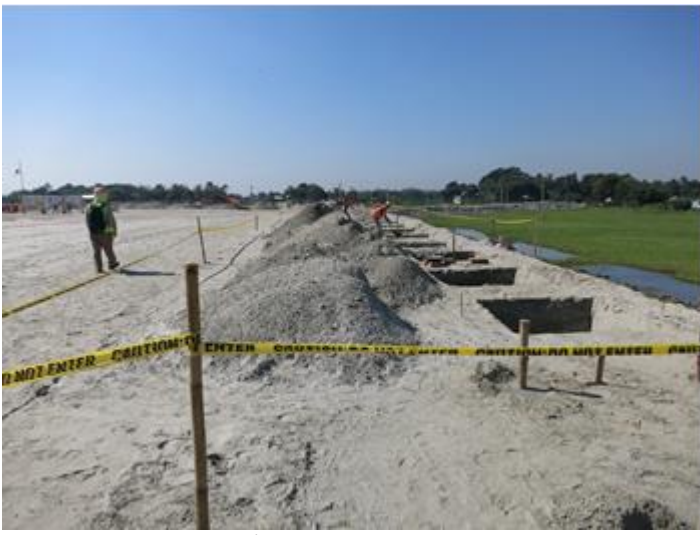
Bangladesh 経済特区での建設工事
