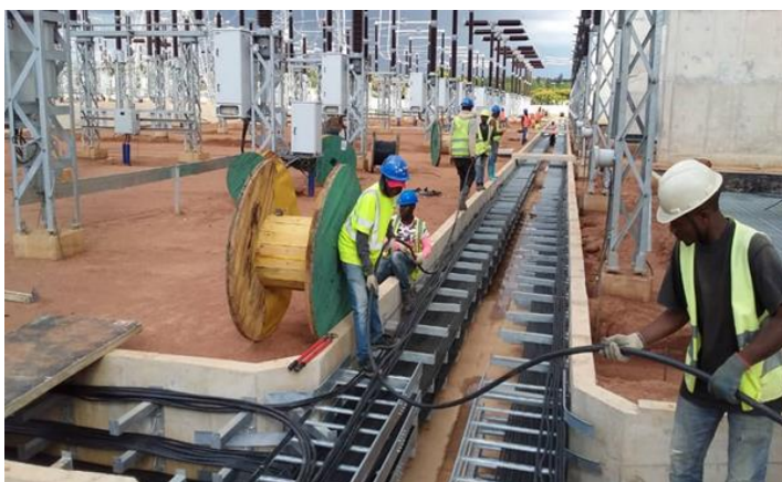
送電線敷設作業
