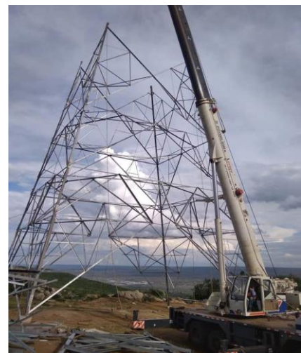
鉄塔建設作業
