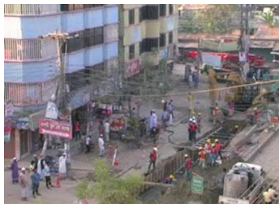
写真3. 配水管敷設工事の様子（JICAプロジェクト資料より）
