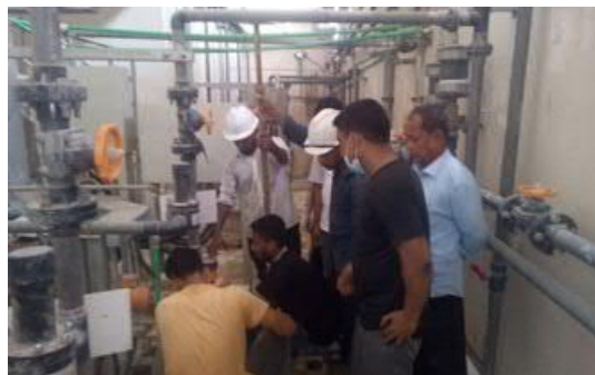
写真4. カルナフリ浄水場 塩素注入装置 の研修（2020年3月、実施機関提供）
