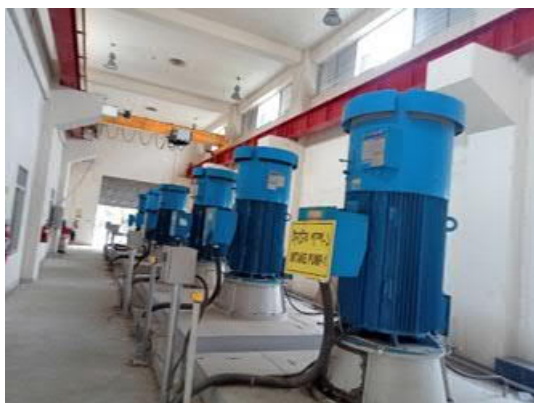
写真2. カルナフリ取水場のポンプステーション（2021年6月、現地調査補助員が撮影）
