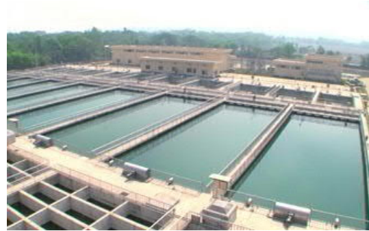
写真1. 本事業で建設されたカルナフリ浄水場 (JICA プロジェクト資料より)
