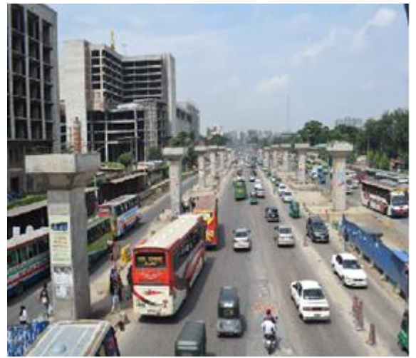
BRT3 号線の脚柱工事 シャージャラル国際空港近郊
