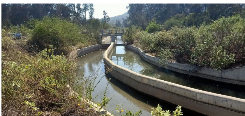
写真 2：本事業で整備された灌漑施設（幹線水路）②
