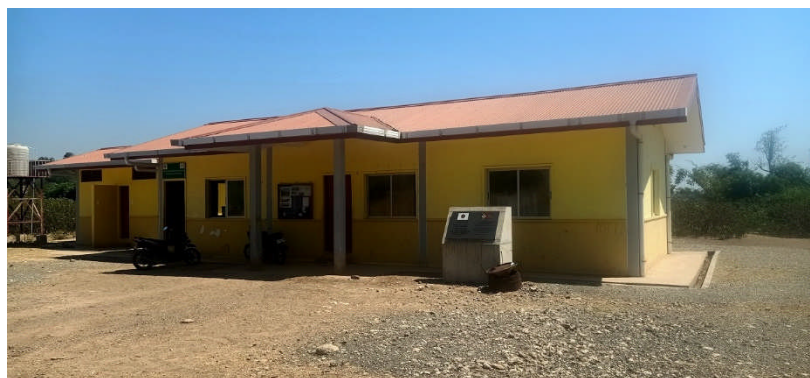
写真 5：本事業で整備された水利組合集会所
