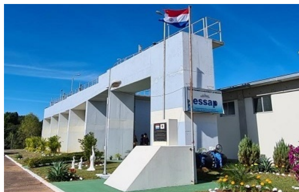
本事業が建設した浄水場
