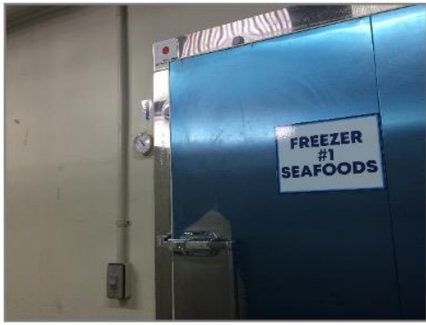
本事業で交換された冷凍庫ドア (カストリーズ)
