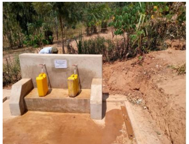
本事業施設から配水管を延長して郡が設置した公共水栓 （ガツィボ郡レメラセクター）
