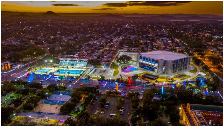
都市公園整備プロジェクトで建設されたアレクシス・アルゲージョ・スポーツセンターとミッシェル・リチャードソン・プール複合施設
