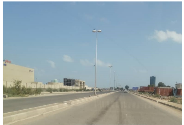
写真 2：道路維持管理機材を活用して整備された ジブチ市内の道路
