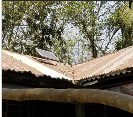
設置された家庭用太陽光発電ソーラーパネル
