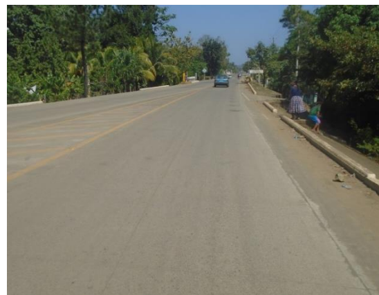
国道7号東線（第4工区）
