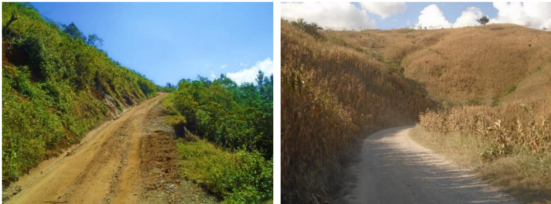
本事業により修復された農村道路
