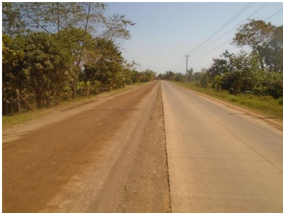
第3工区の未舗装区間
