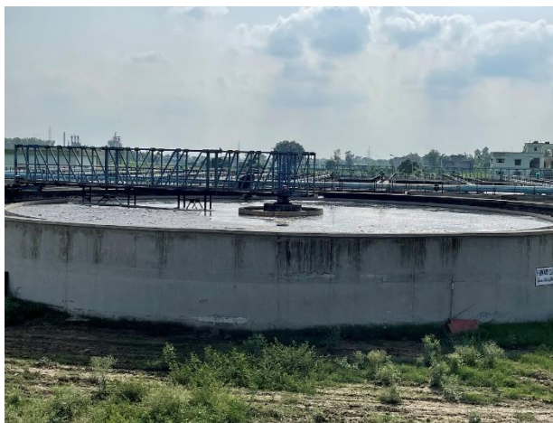
本事業で建設した下水処理場（沈殿池）
