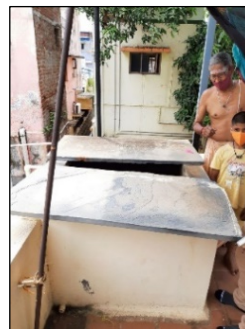
屋上の貯水用タンク
