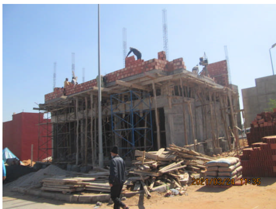
写真 3：建設中の住宅
