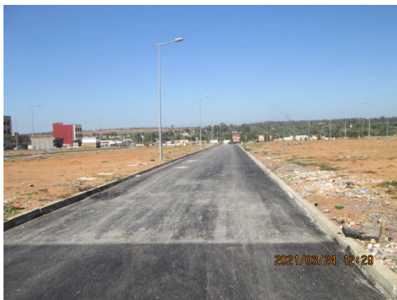
写真 1：整備された道路
