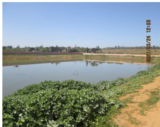
写真 2：整備された雨水調整池
