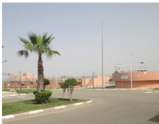
写真 2 : OCP 資金により整備された下水処理施設全景 (ベン・ゲリール市)
