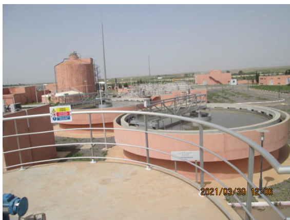
写真 1 : OCP 資金により整備された下水処理施設内の様子 (ベン・ゲリール市)
