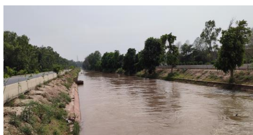
本事業で整備された三次水路
