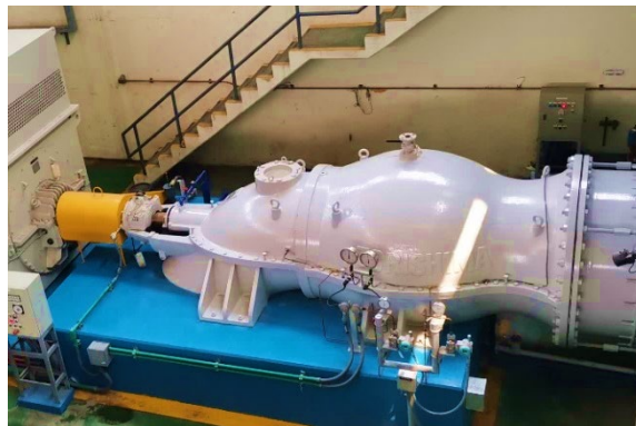
バンケン浄水場の原水ポンプ (左)、送水ポンプ (右)
