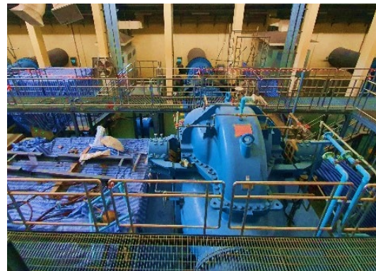
バンケン浄水場の原水ポンプ (左)、送水ポンプ (右)
