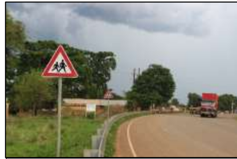
設置されたガードレール、道路標識
