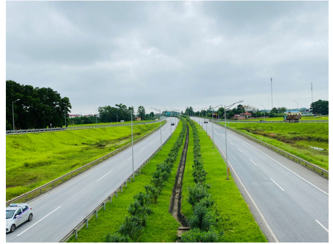
本事業で整備された国道3号線
