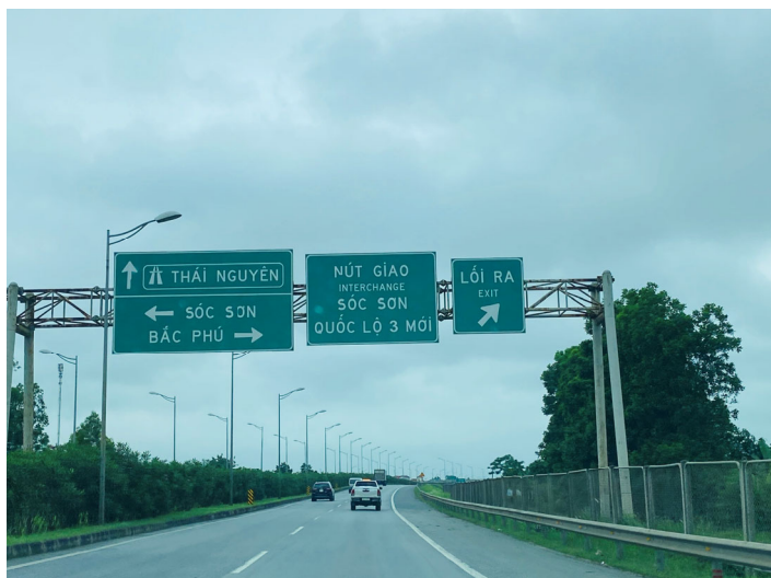
本事業で整備された国道 3 号線
