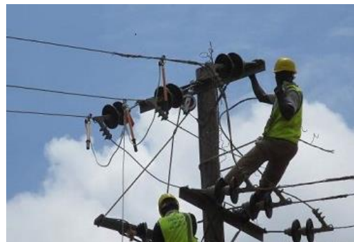
配電線改修の OJT (出典: 終了時評価報告書 p23)
