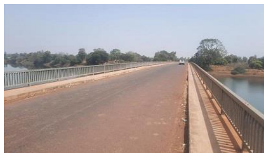
バフィン橋 (現地調査補助員撮影)
