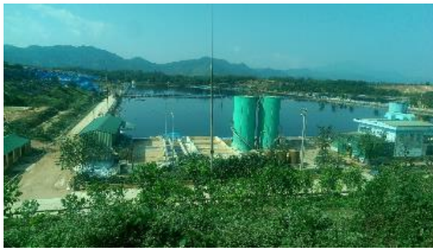
ソックソン（ナムソン）廃棄物複合施設の浸出水処理用池
