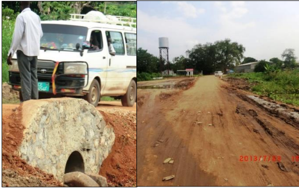
新設のカルバート（左）と修復により直進できるようになった道路（右）（2013年9月） 出所：プロジェクト実施チーム
