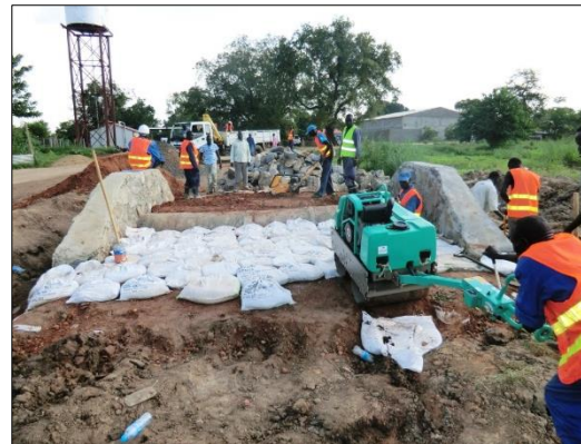
土のうによる修繕のOJT（2013年9月）
