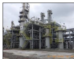
天然ガス生産プラント
