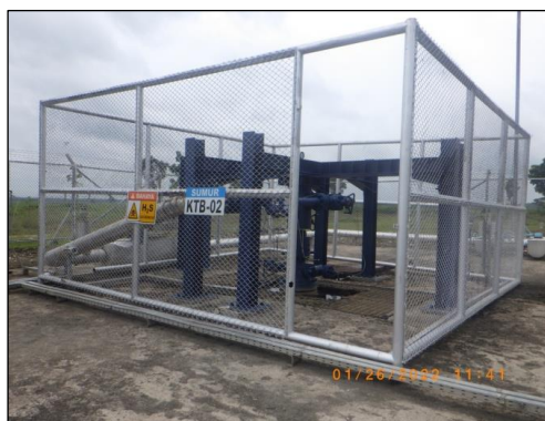
グンディガス田の CO 2 圧入を予定している井戸
