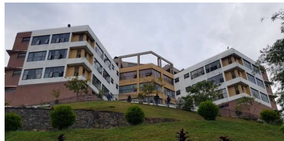
ワラカポラ BH 新病院棟
