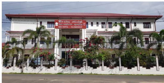
カルワンチクディ BH 新病院棟
