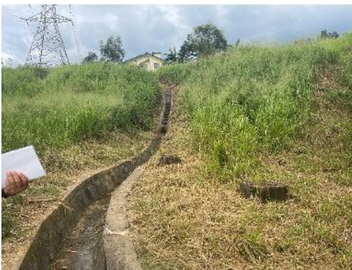
（バドゥッラ・バドゥルスリガマ地区の排水溝） 損傷なく良好に機能している。
