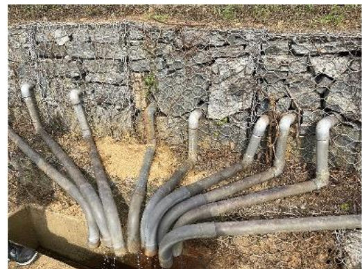
（水平ドレーン） 良好に機能している。
