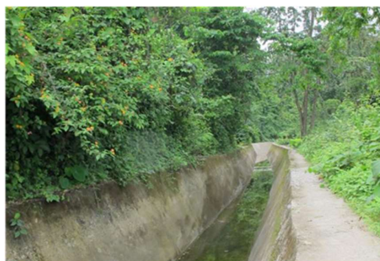
高位部幹線水路
