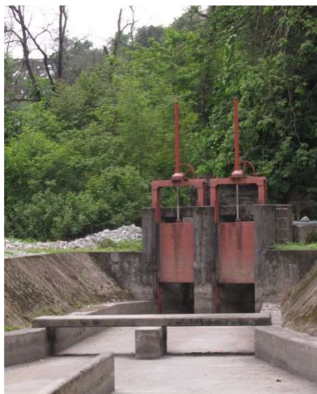
幹線水路のゲート
