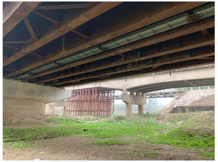
モホスタン橋（修繕された古い橋梁と新しい橋梁）
