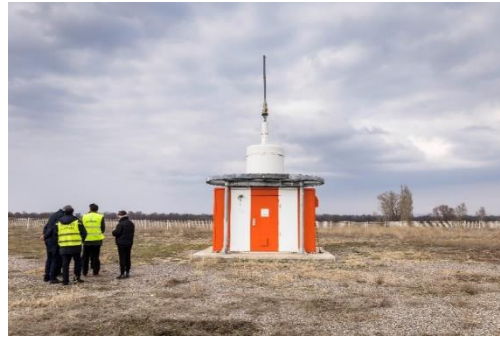
航空保安機材の超短波全方向式無線標識局/距離測定装置 (VOR/DME) (出典：JICA)
