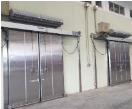
(写真左) 冷蔵・冷凍施設
