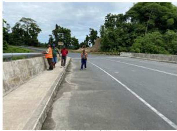
橋梁に設置された緑石歩道 (アウム橋) (出所：外部評価者)
