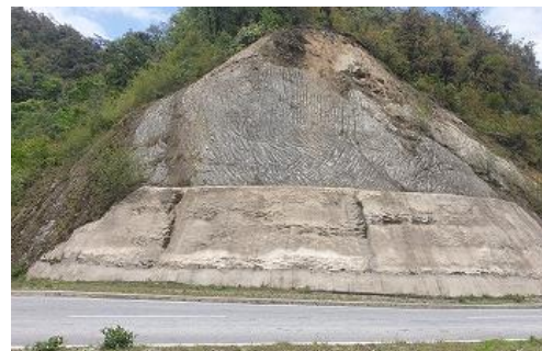
ザラムチュ橋取付け道路沿いの法面モルタル吹き付け
