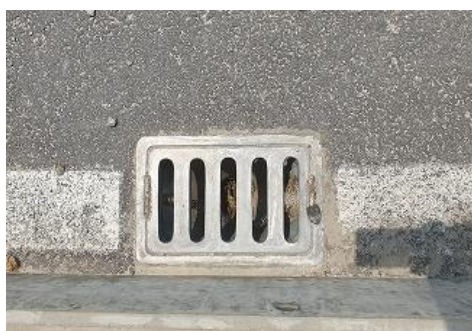
チュゾムサ橋の排水溝
