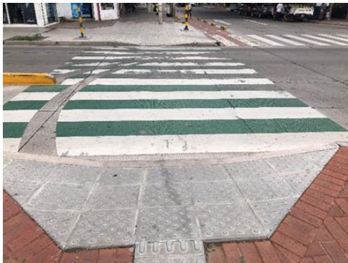
歩道の点字ブロック
