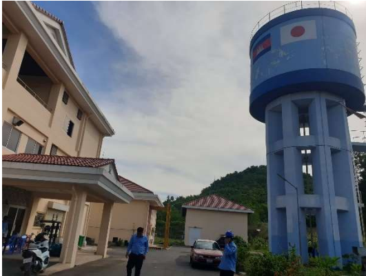
管理棟と高架水槽
